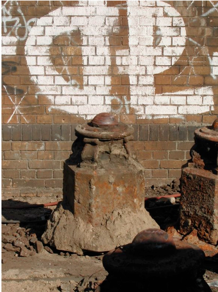
2005 Pendelstützen der Stadthausbrücke im Abbruch
